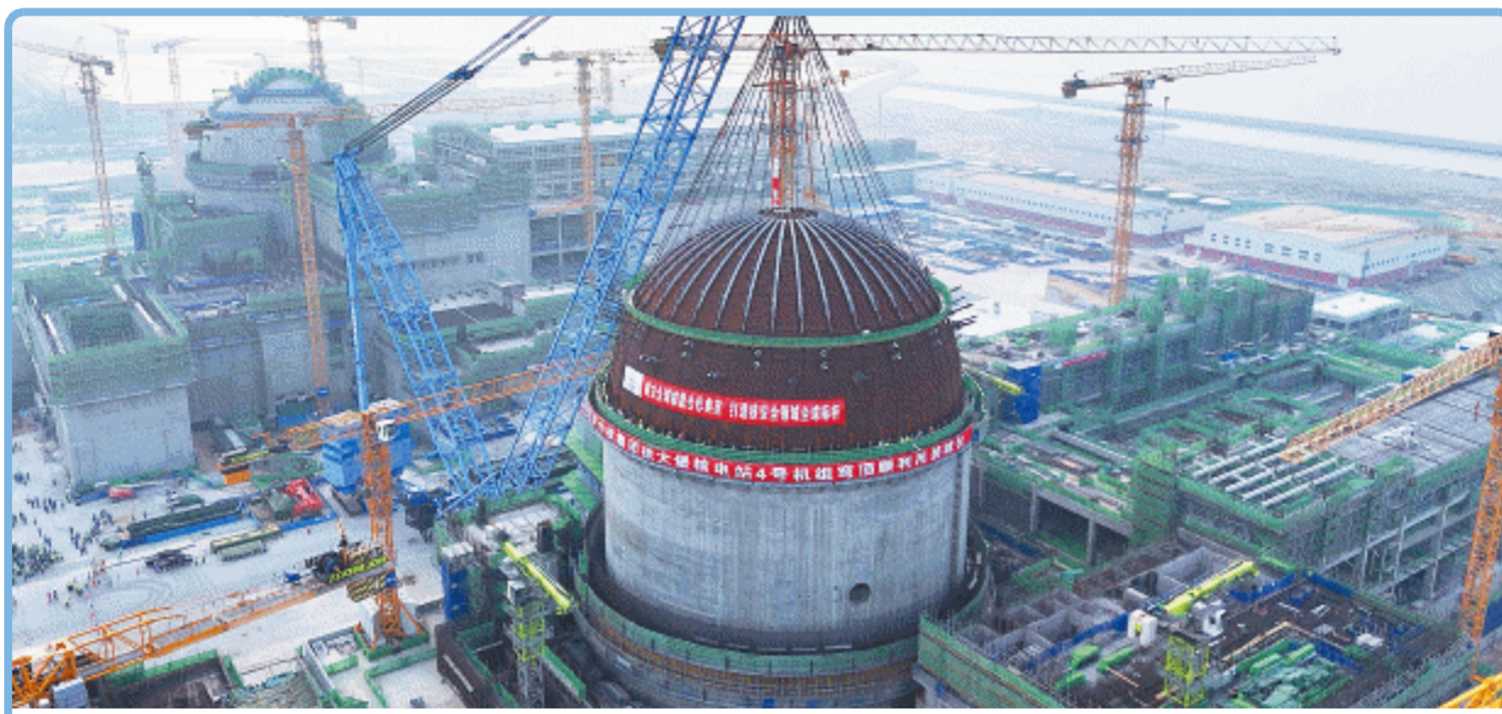
徐大堡核电站 4号机组穹顶吊装就位
