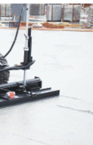
“机器人班组”中的四轮激光地面整平机器人。受访方供图
